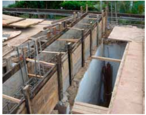
Ein Obergurt (Ringanker) aus Stahlbeton stabilisiert die neue Konstruktion
